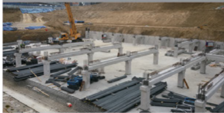
① PC 부재 설치(지하2층)
