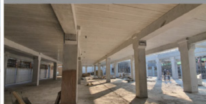
④ PC 부재 설치
