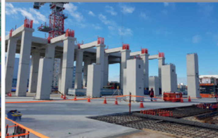
② PC 부재 설치
