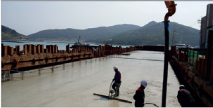
④ 토핑콘크리트 타설
