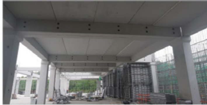
③ PC 부재 설치
