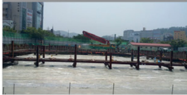
③ 토핑콘크리트 타설
