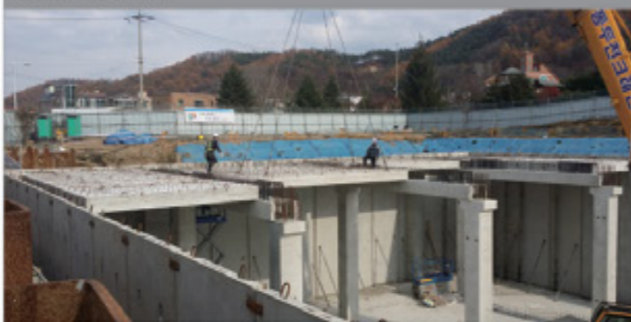
② PC 부재 설치
