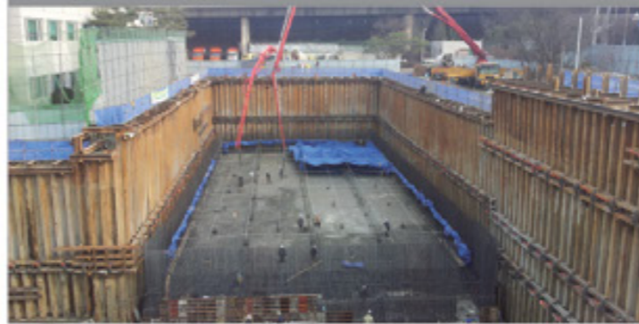
① 기초콘크리트 타설
