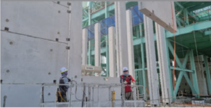
② PC 부재 설치
