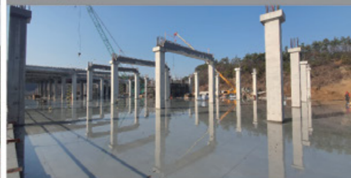
② PC 거더 설치
