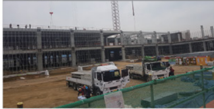
① PC 부재 설치
