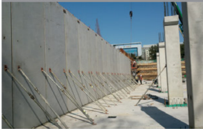
① PC 부재 설치
