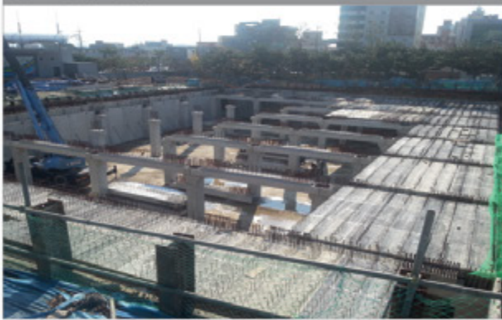
② PC 슬래브 설치
