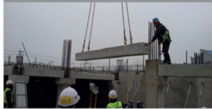
③ PC 거더 설치
