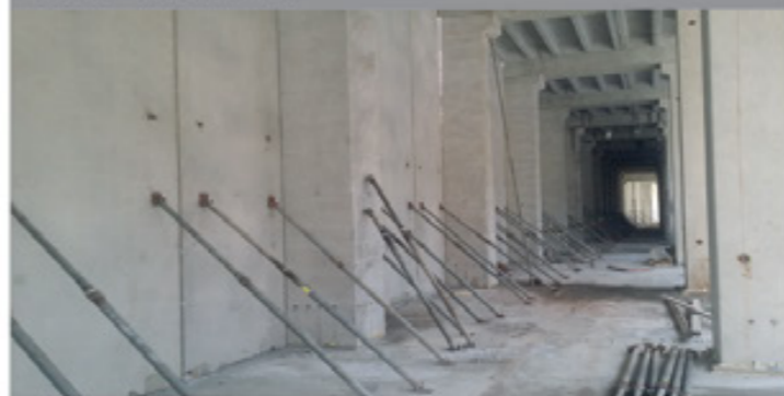
③ PC 부재 설치(약사천)
