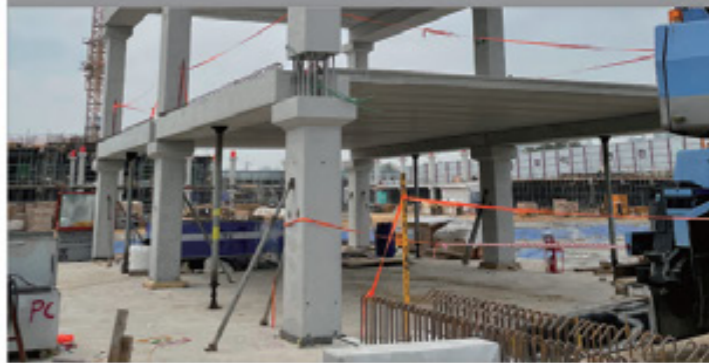
④ PC 슬래브 설치
