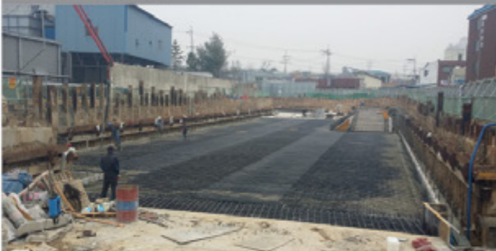
③ 토핑콘크리트 타설
