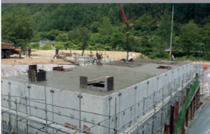
② 토핑콘크리트 타설
