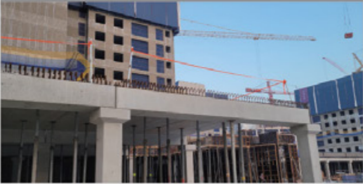
④ PC 부재 설치
