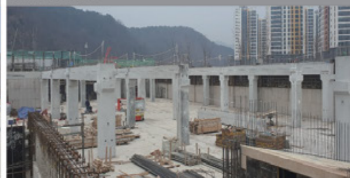
② PC 거더 설치
