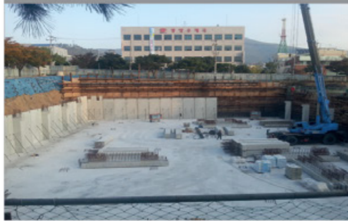
① PC 부재 설치
