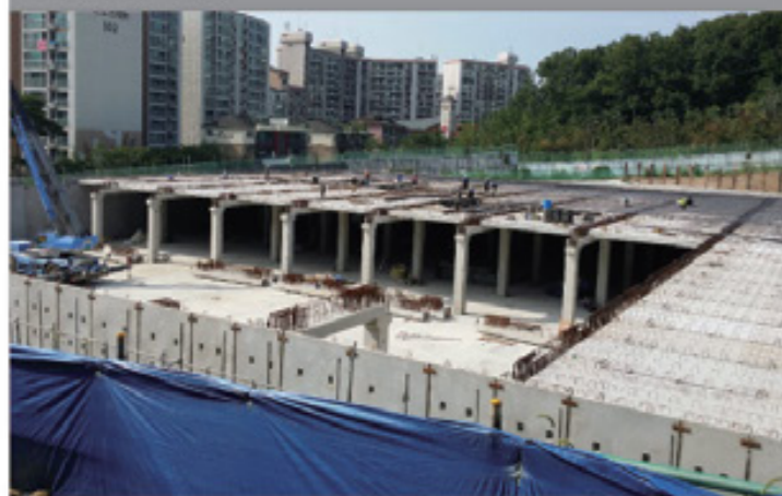
① PC 슬래브 설치
