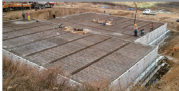
③ 토핑콘크리트 타설
