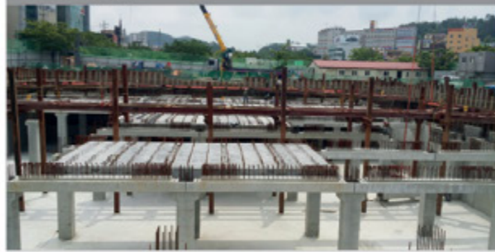
① PC 부재 설치
