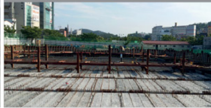
② PC 부재 설치
