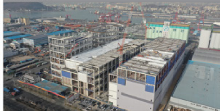
② 현장 전경
