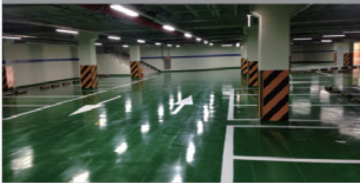
④ 내부 전경(지하주차장)
