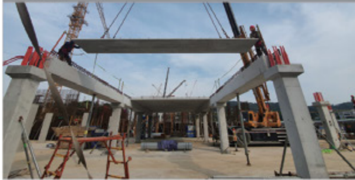
③ PC 슬래브 설치
