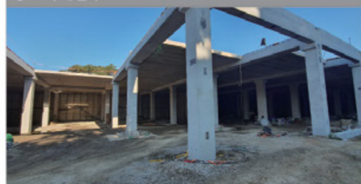
③ PC 부재 설치
