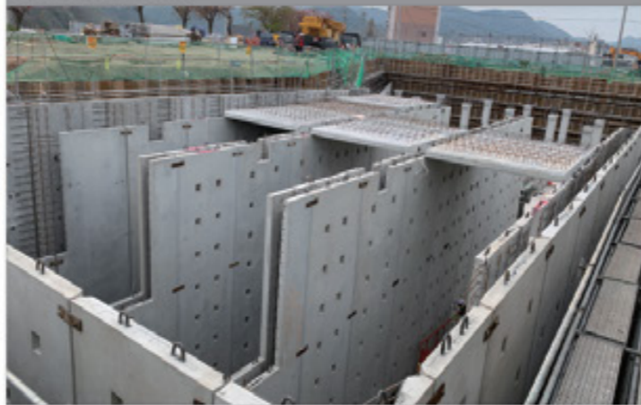
② PC 슬래브 설치
