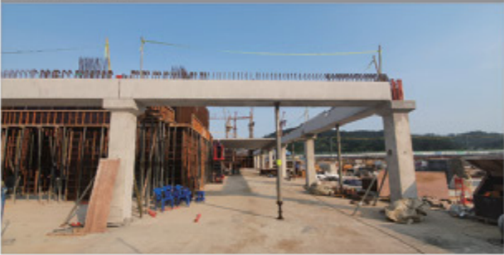
② PC 거더 설치
