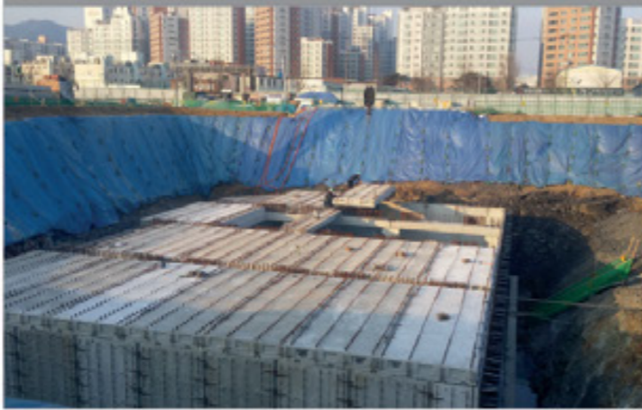
② PC 슬래브 설치
