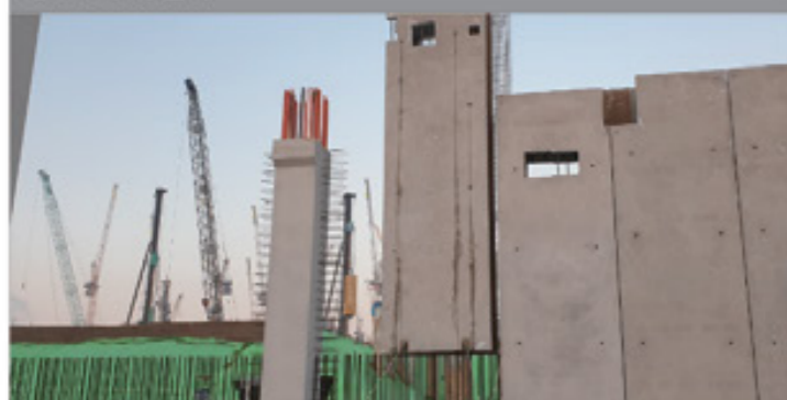
① PC 부재 설치
