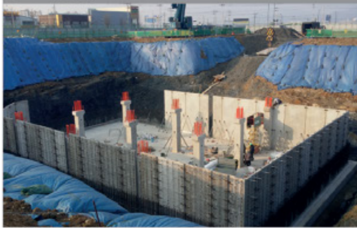
① PC 부재 설치
