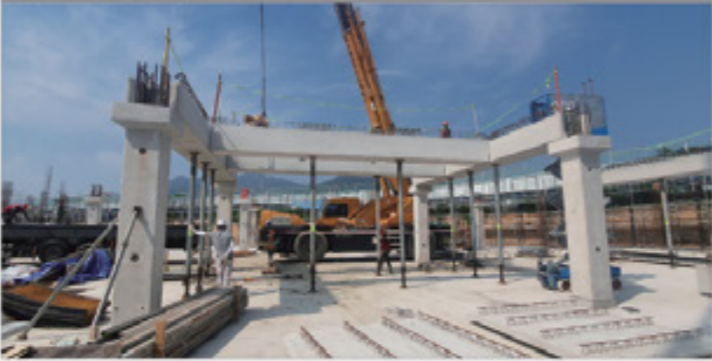
② PC 거더 설치
