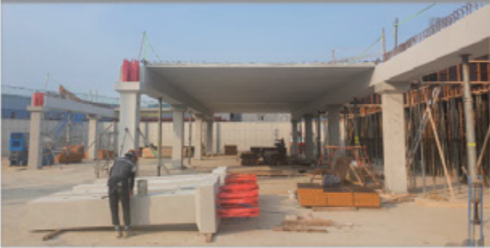
④ PC 부재 설치
