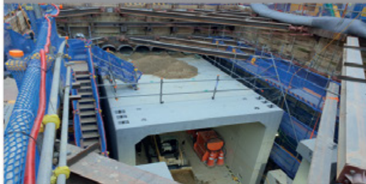
② PC 부재 시공(프론트잭킹 공법)
