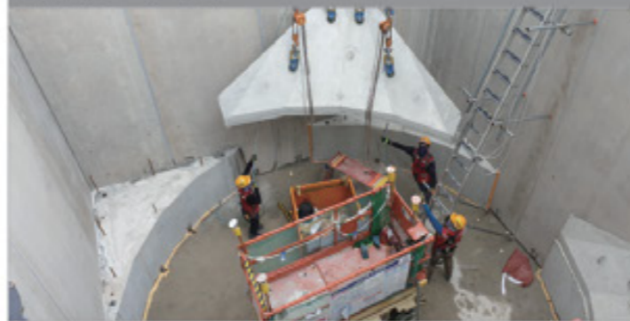
③ 벤칭콘크리트 설치
