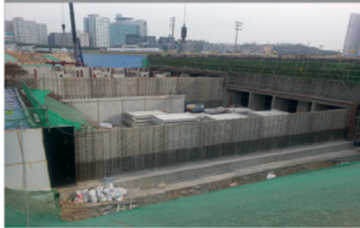
① PC 벽체 설치(FAB동)
