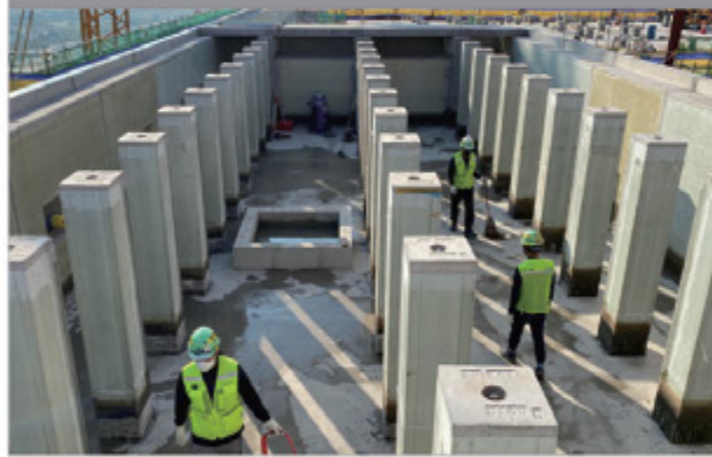
① PC 부재 설치
