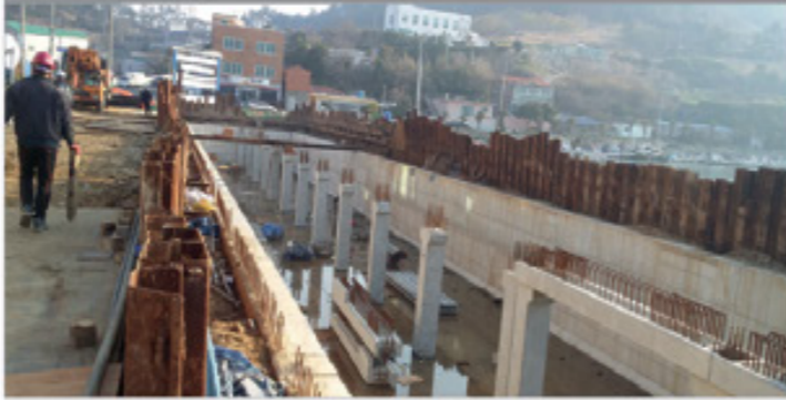
② PC 부재 설치
