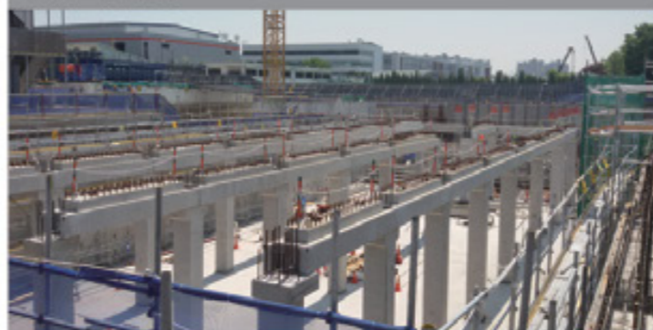
③ PC 거더 설치
