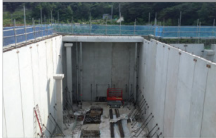
① PC 부재 설치
