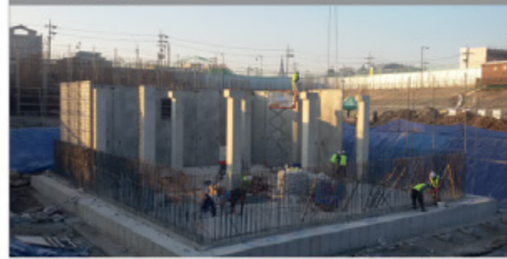
① PC 부재 설치
