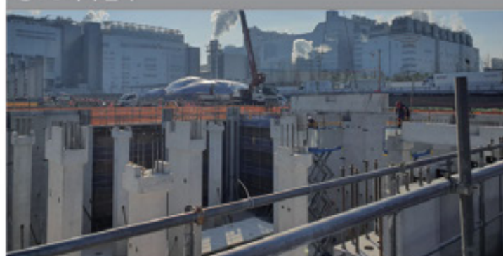
③ PC 거더 설치
