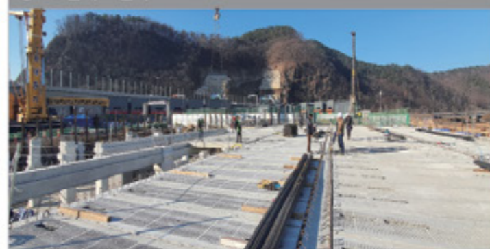
③ PC 슬래브 설치
