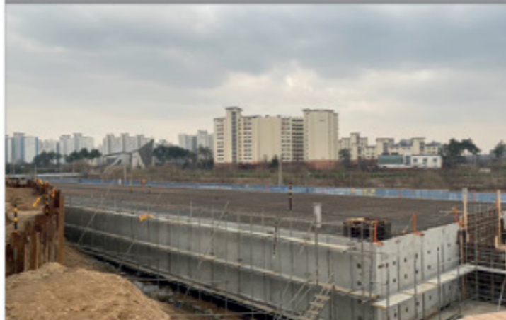
② 현장 전경
