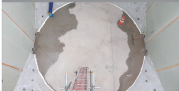
④ 벤칭콘크리트 설치
