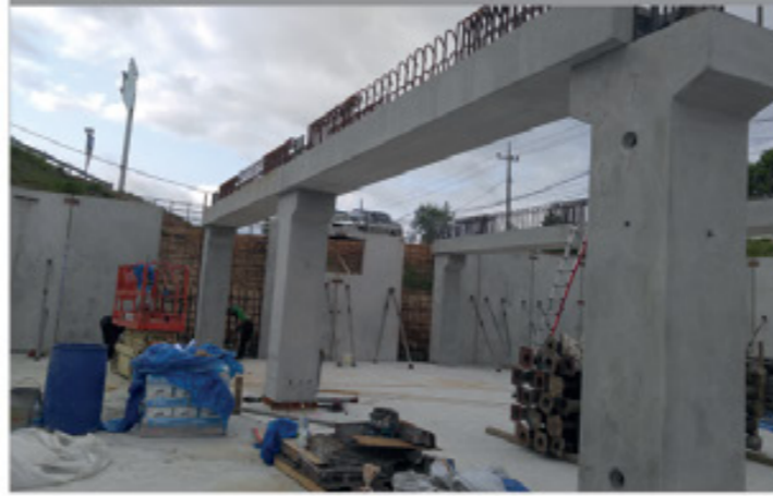
① PC 부재 설치
