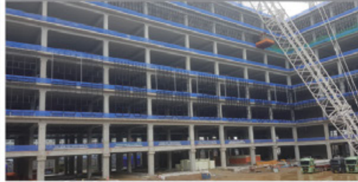
② PC 부재 설치
