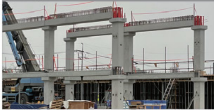
② PC 거더 설치
