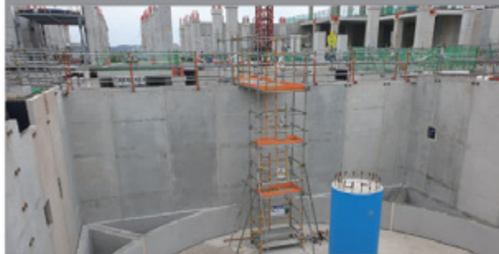
② 벤칭콘크리트 설치
