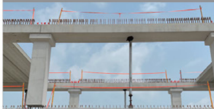
③ PC 거더 설치
