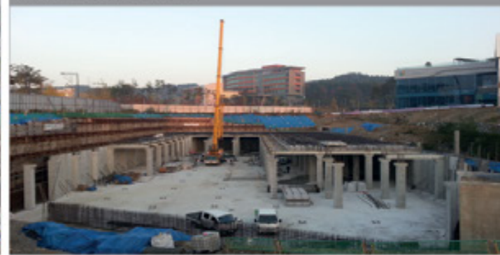
② PC 부재 설치(복사천)
