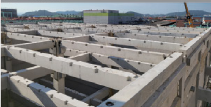
③ PC거더, 빔 설치
