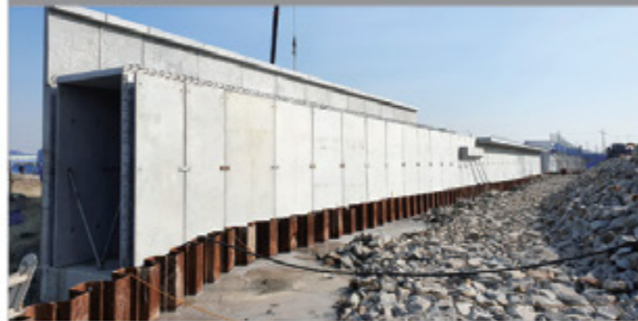
③ PC 부재 설치
