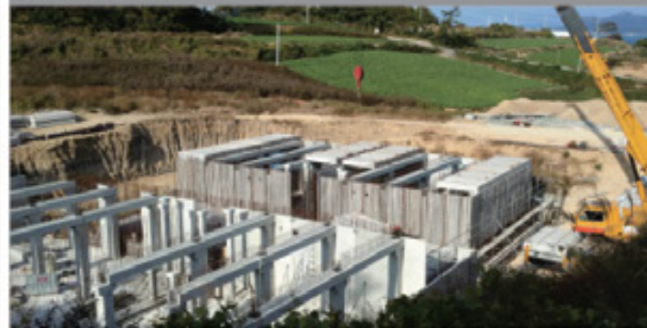
② PC 부재 설치
