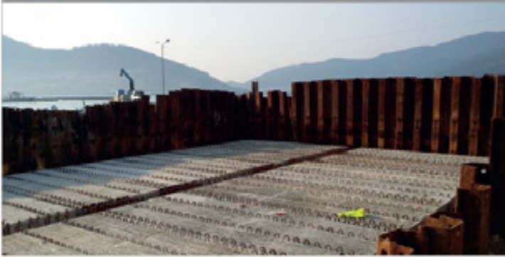
③ PC 슬래브 설치
