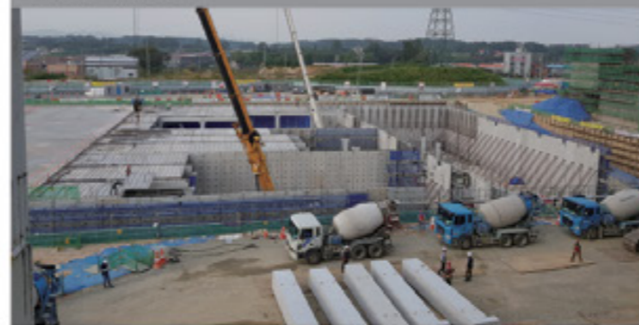
③ PC 부재 설치
