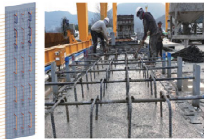
2. 철근 조립 및 콘크리트 타설
