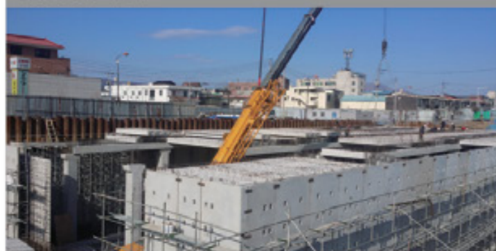
③ PC 슬래브 설치
