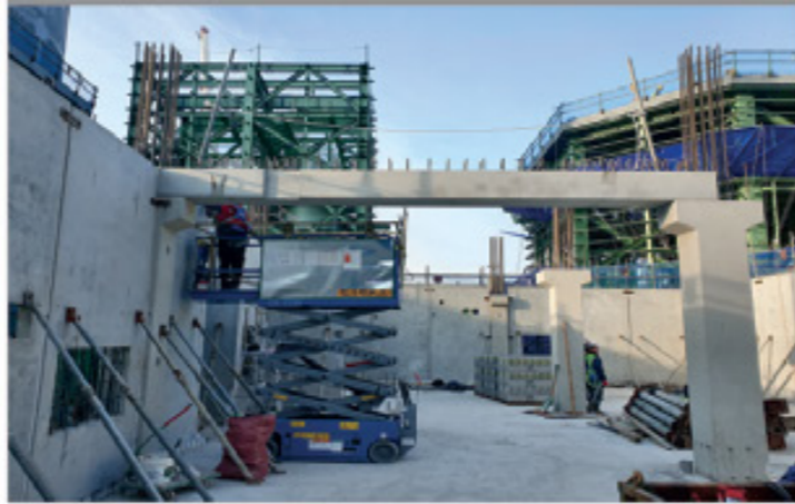
② PC 거더 설치
