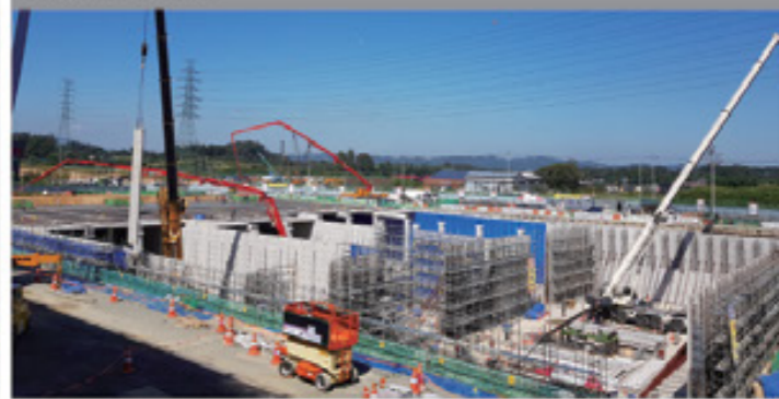
② PC 부재 설치
