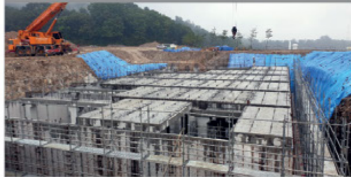
③ PC 슬래브 설치
