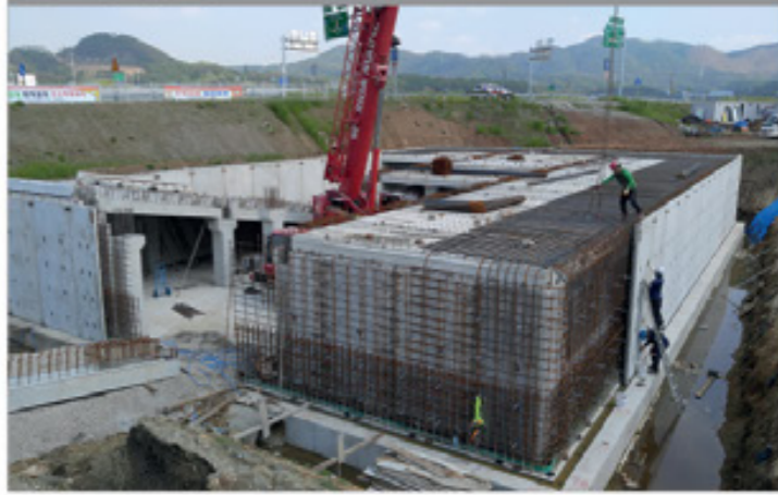
② PC 부재 설치
