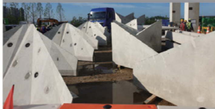
① PC 부재 설치
