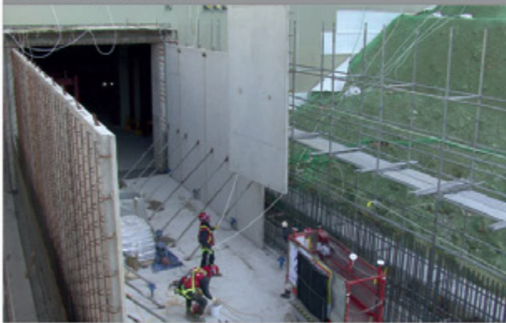
② PC 슬래브 설치(그린3동)
