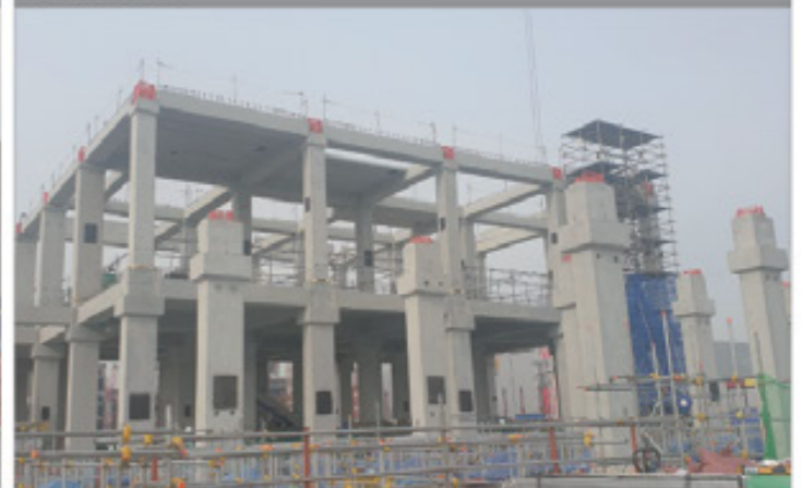
② 현장 전경
