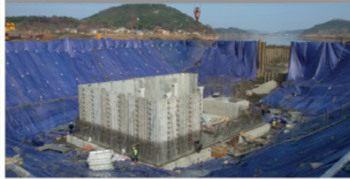
② PC 부재 설치
