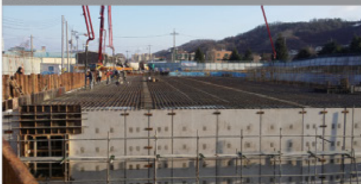
④ 토핑콘크리트 타설
