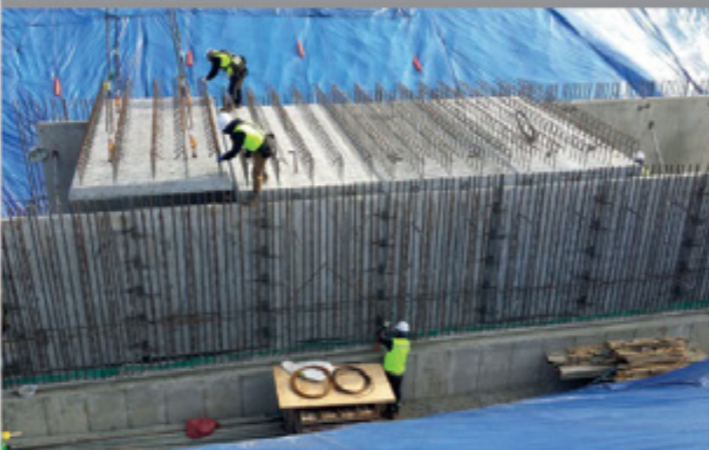
② PC 슬래브 설치
