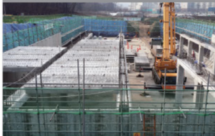
① PC 거더 설치
