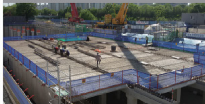
④ PC 슬래브 설치
