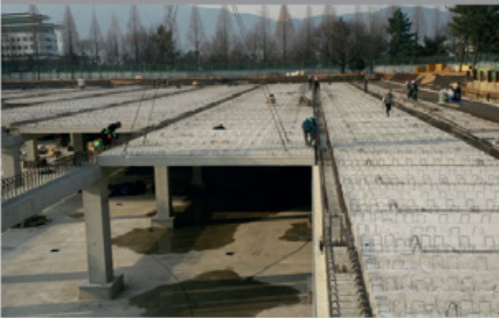
② PC 슬래브 설치
