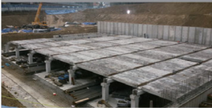
② PC 슬래브 설치(지하2층)
