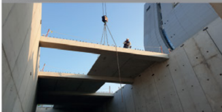
③ PC 슬래브 설치
