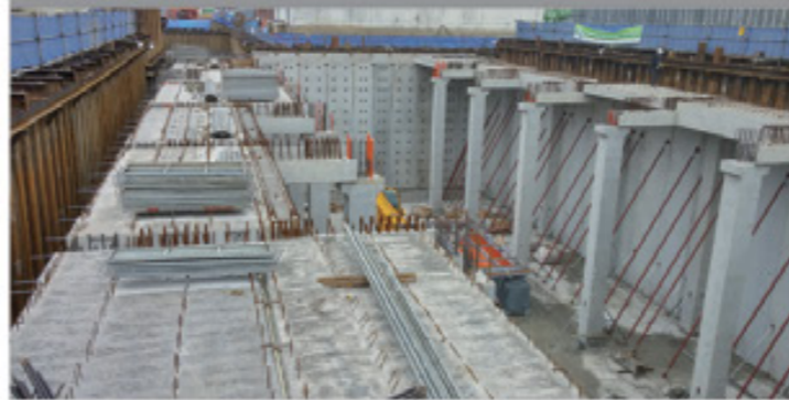
③ PC 부재 설치
