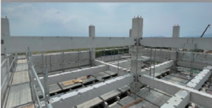
① PC거더, 빔 설치
