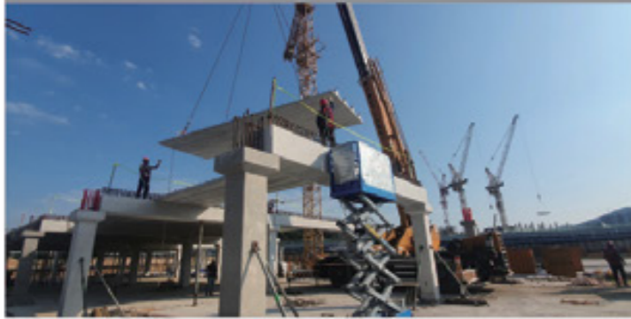
③ PC 슬래브 설치
