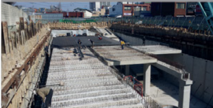
② PC 슬래브 설치
