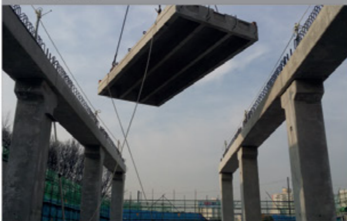
② PC 슬래브 설치
