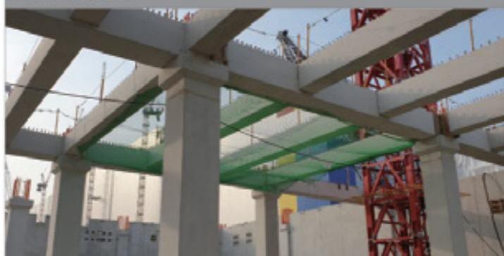
② PC 부재 설치
