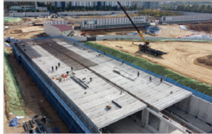
① PC 부재 설치
