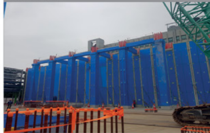
① PC 부재 설치
