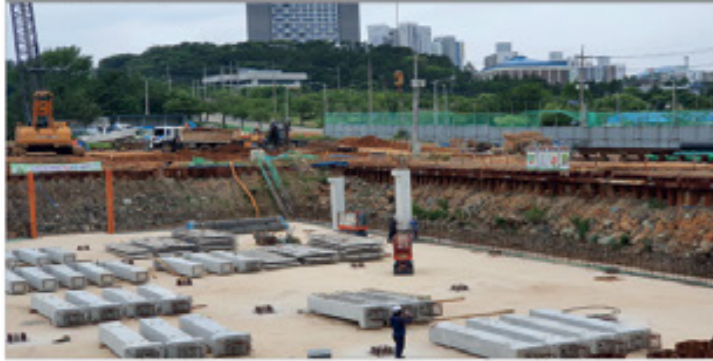
① 부재반입 및 PC 기둥 설치
