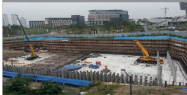
① PC 기둥 설치(복사천)
