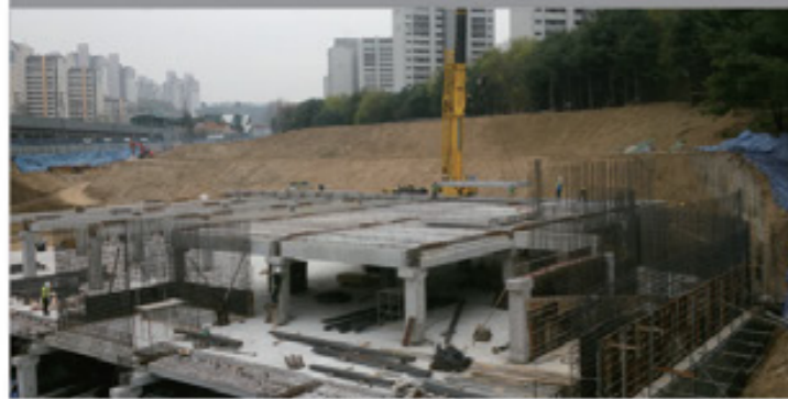
③ PC 부재 설치(지하1층)
