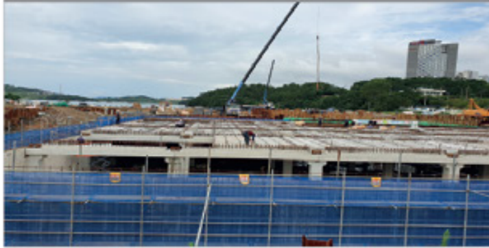
③ PC 슬래브 설치
