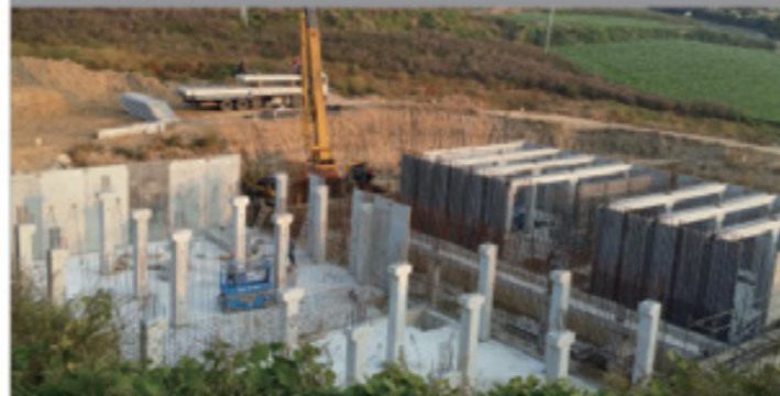
① PC 부재 설치
