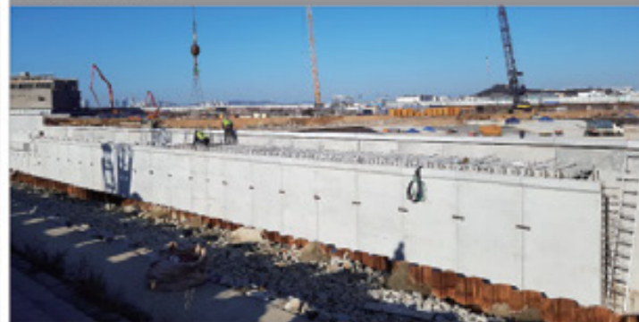
② PC 부재 설치
