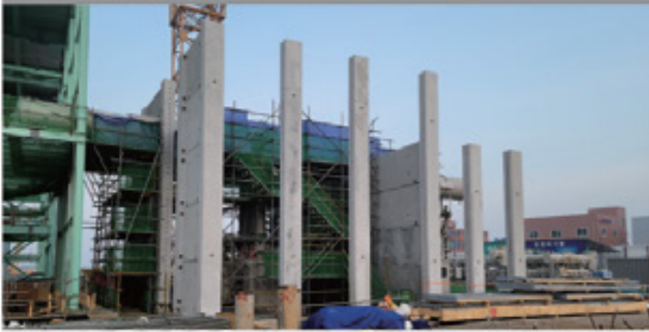
① PC 부재 설치
