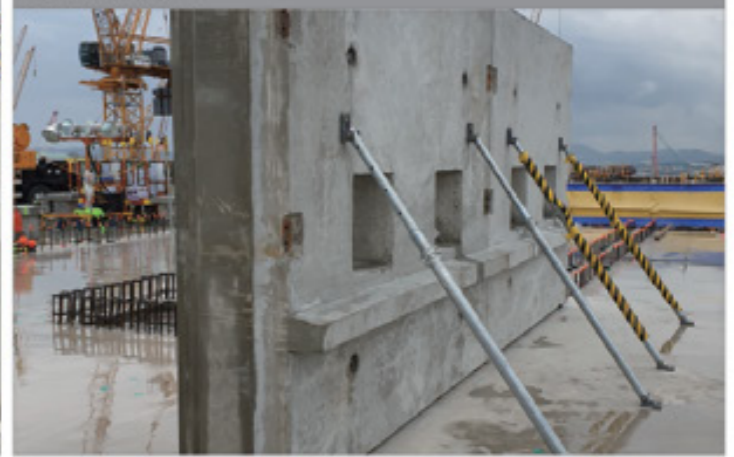
② PC 부재 설치
