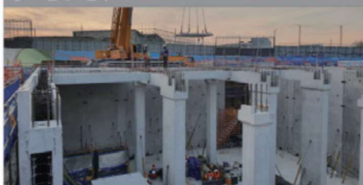
④ PC 슬래브 설치
