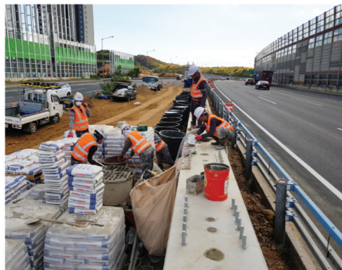
⑤ H-PILE 접합부 무수출몰탈 주입
