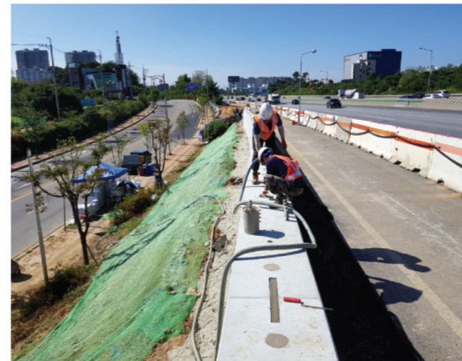
⑤ H-PILE접합부 무수축몰탈 주입
